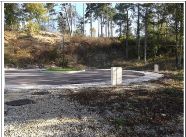
11 Parcelles viabilisées en attente de constructions
