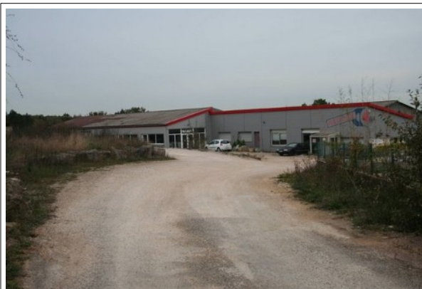
Ancienne casse auto au Nord du village
