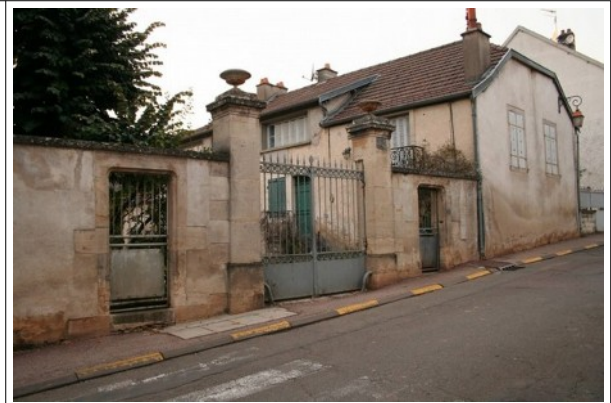
A l'alignement sur rue on trouve souvent des façades pignon, la façade principale donnant sur la cour.
