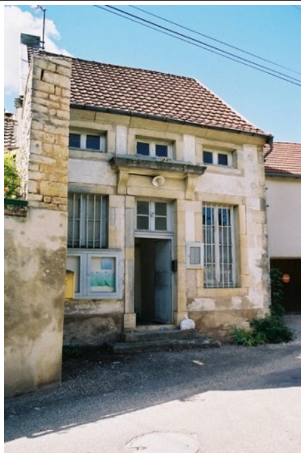
Ancienne mairie de Vantoux avant rénovation (20)
