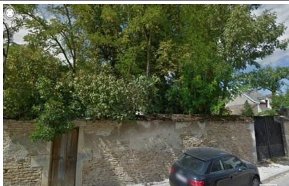
Murs en pierre, porte en bois et jardins se combinent parfaitement et créent un paysage de la rue agréable
