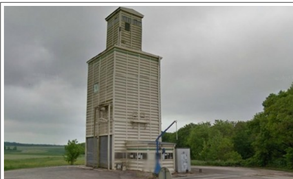
Silo fortement perçu au Sud de la commune
