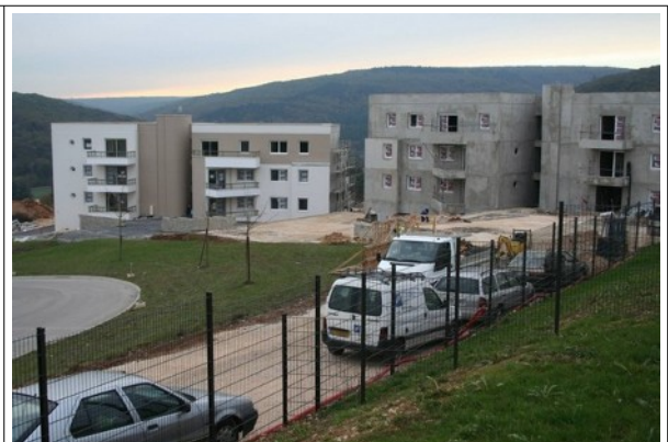
55 Résidence les Hauts de la Combe, construite sur les hauteurs de la commune, un habitat contemporain dans le cadre exceptionnel du Suzon mais également fortement visible dans le paysage
